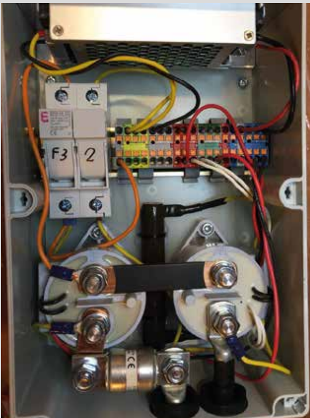
Elektrokomponenten in einer Box, steckerfertig
