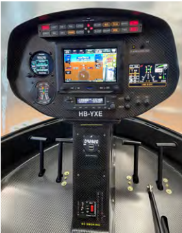
Das Panel ist fertig verdrahtet und zum ersten mal unter Strom Le panneau est câblé et sous tension pour la première fois
